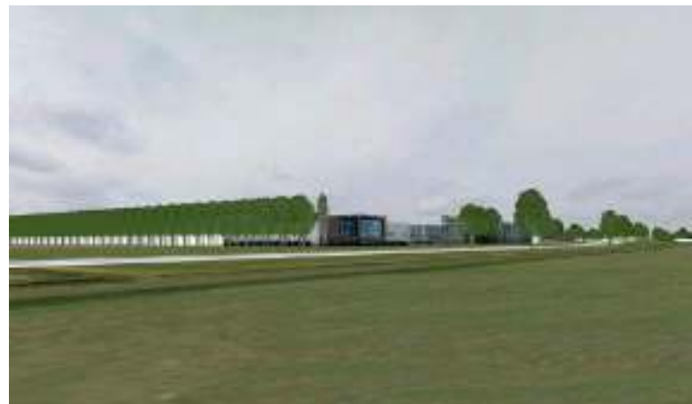
Impressie zicht op 1e fase 't Zevenhuis vanaf de huidige Westfrisiaweg. De bebouwing richt zich naar de nieuwe weg en de rij populieren zorgt voor een groene afzoming van de (tijdelijke) westelijke gebiedsgrens.
